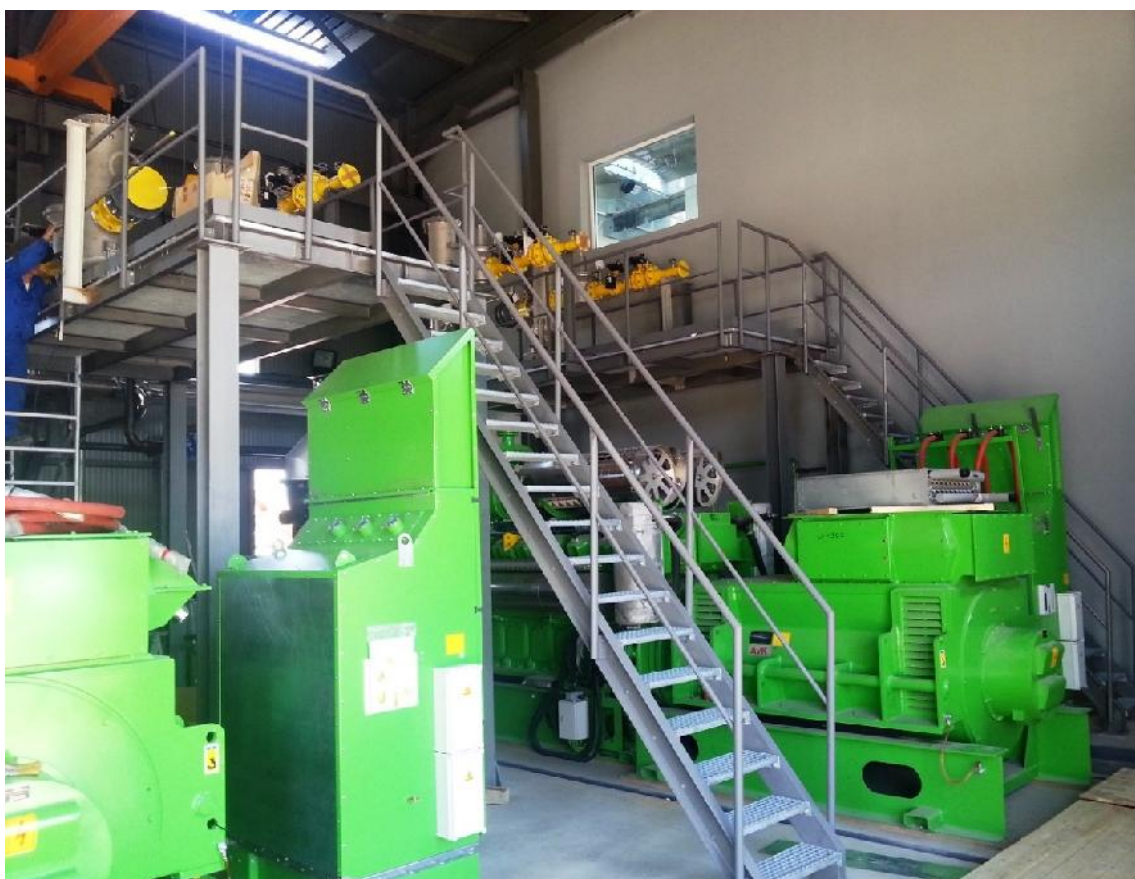
Detalle interior sala de motogeneradores GE Jenbacher
