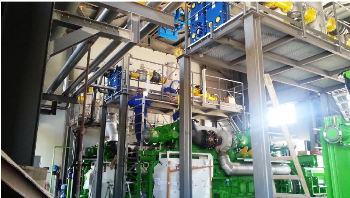
Vista ampliada de los 3 motogeneradores GE Jenbacher y rampas de syngas en fase de montaje
