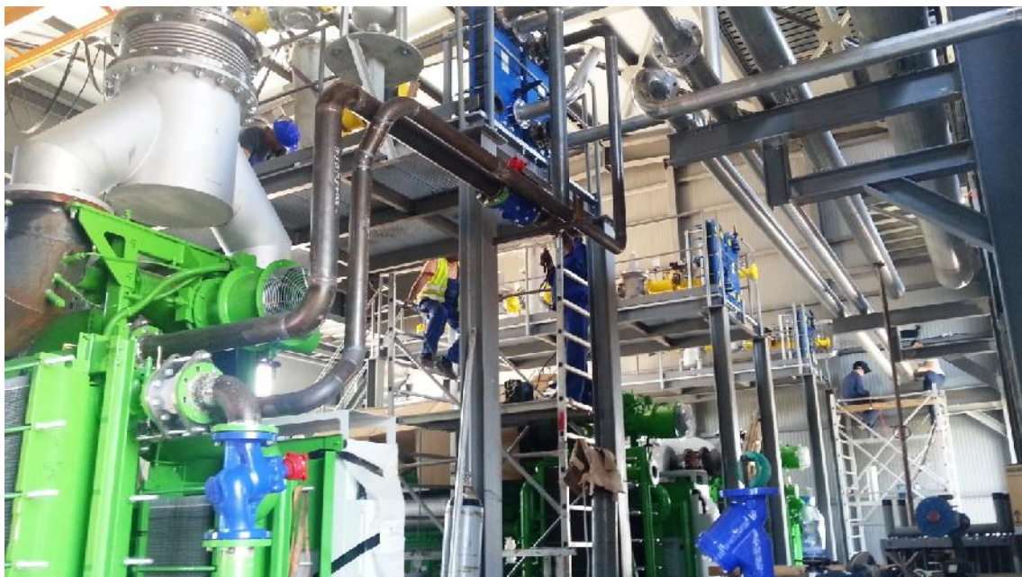
Otra vista ampliada de los 3 motogeneradores GE Jenbacher y rampas de syngas en fase de montaje
