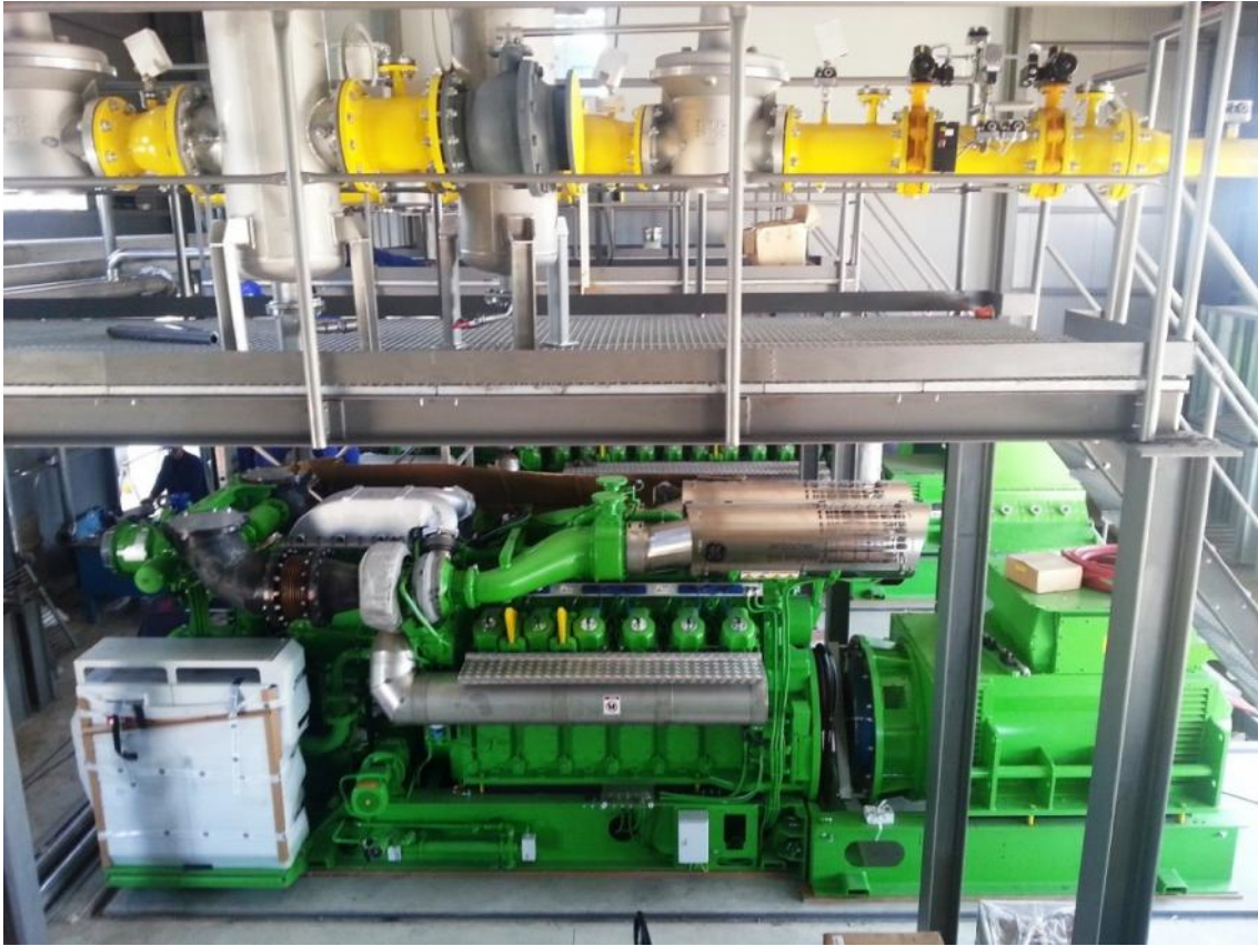
Vista detallada del motogenerador GE Jenbacher JMS612 y rampa de syngas
