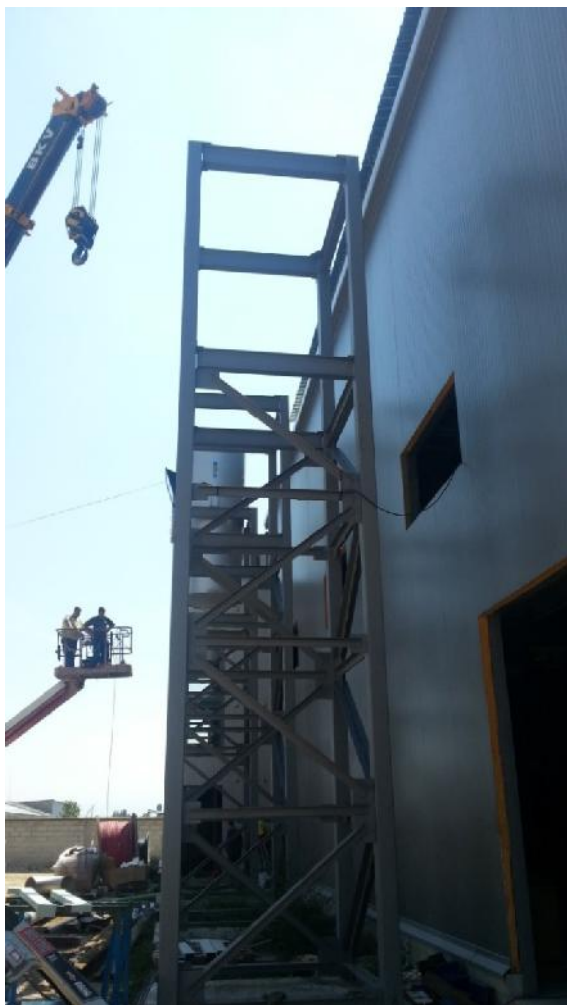
Montaje de los silenciadores de los gases de escape de los motogeneradores.
